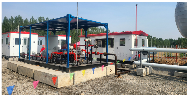
胜利油田 CCUS 密相 CO 2 注入泵
